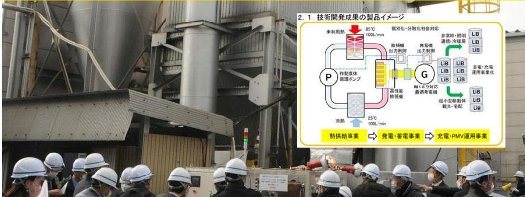
小型 ORC(O:オーガニック・R:ランキン・C:サイクル)発電システムは、80～90℃お湯毎分 100 L/min 程度と 20～35℃の冷水毎分 100L/min 程度を装置に流すと、有効電力 4.5～5.0 kW 程度が得られる装置です。工場や温泉熱などの廃熱を利用して発電し SDGs・カーボンニュートラルへ貢献します。
